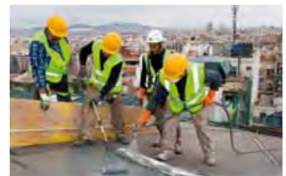
Colocación del Impermax + Rayston Fiber
