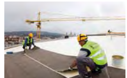
Colocación de la lámina Rayston Vel
