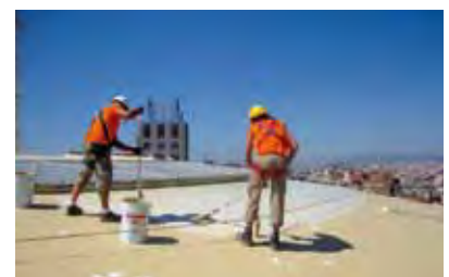
Impermax + Capa de acabado (Colodur)
