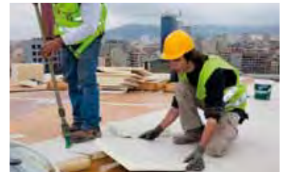
Colocación del Rayston FOAM (capa aislante)
